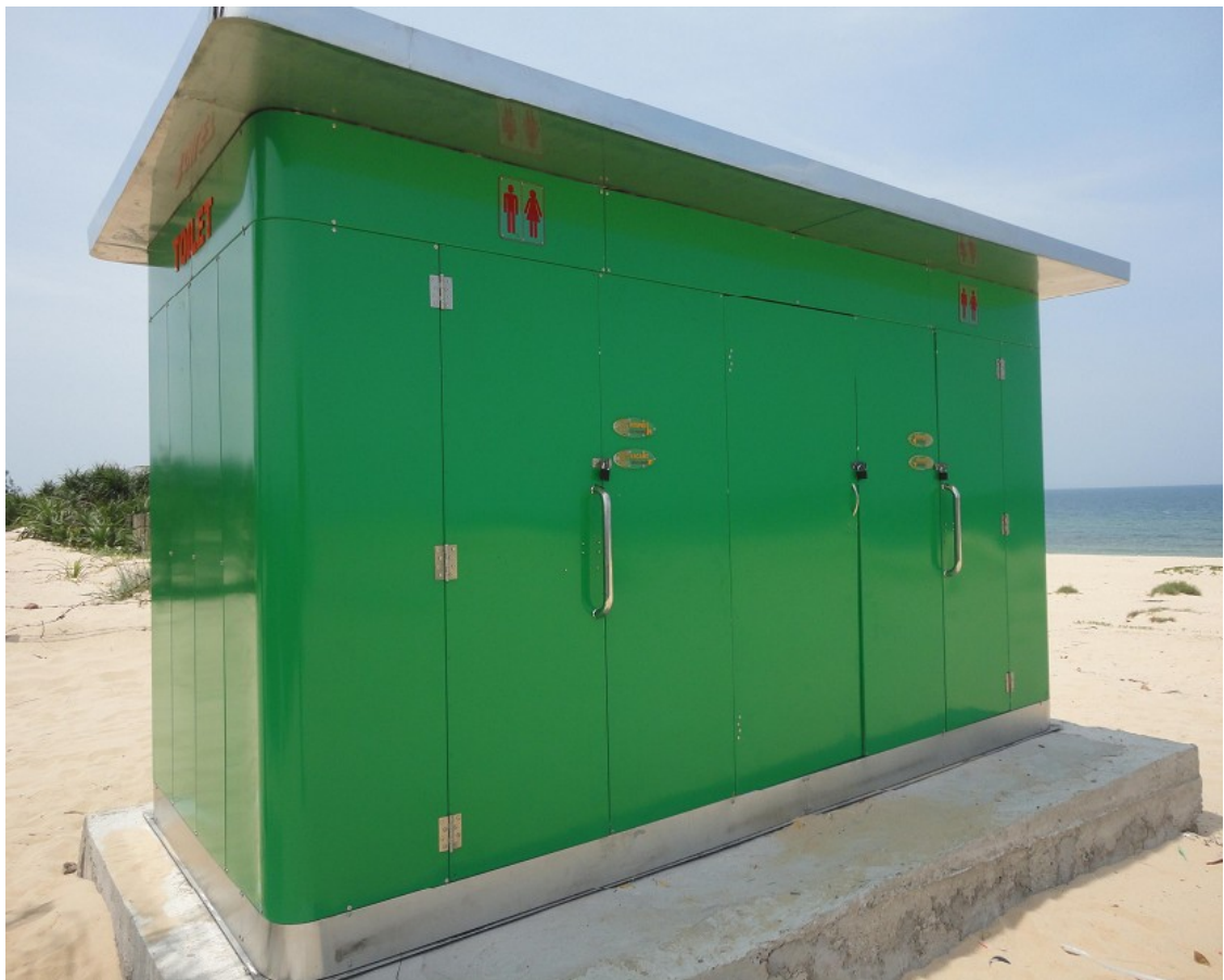
Nhà vệ sinh công cộng bán tự động model MC-808 lắp đặt tại TP. Đồng Hới
