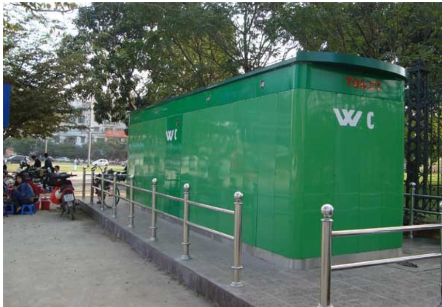
Nhà vệ sinh công cộng bán tự động 4 buồng, lắp tại phố Nguyễn Văn Huyền – Công viên Nghĩa Đô – Hà Nội
