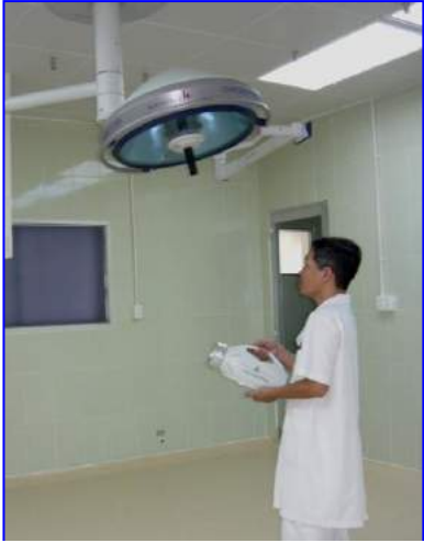
Sau thi công lắp đặt, Hệ thống UCASS được kiểm nghiệm và cấp chứng nhận đạt chuẩn vi sinh WHO
