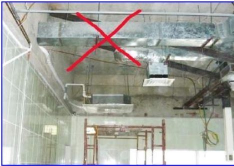
Hệ thống lạnh trung tâm với các đường ống thông nhau đã gây lây nhiễm chéo cho các phòng mổ tim, nên từ năm 2010, Bệnh viện Chợ Rẫy đã cho tháo dỡ và thay thế toàn bộ hệ thống cấp khí siêu sạch áp lực dương công nghệ UCASS-X7G
