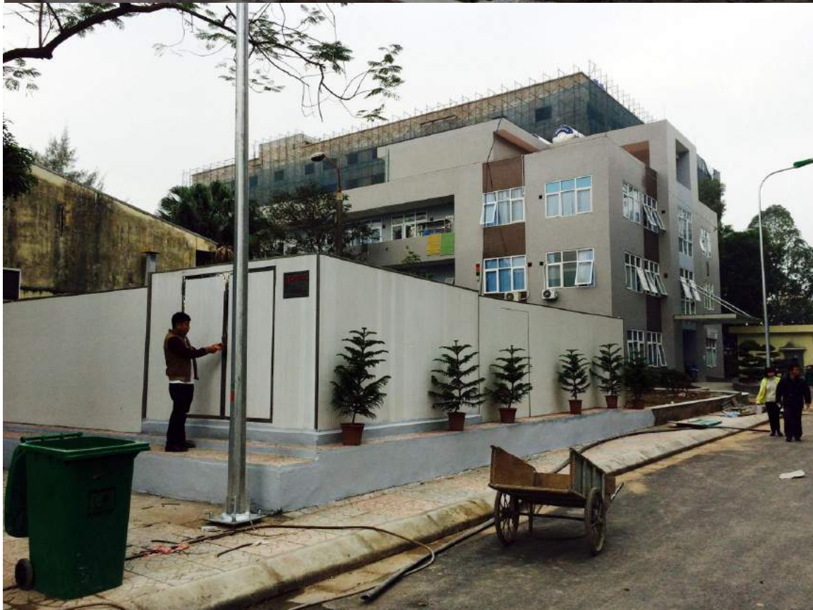
Hệ thống xử lý nước thải Bệnh viện đa khoa Đức Giang – Hà Nội, Công suất: 500m 3 /ngày.
