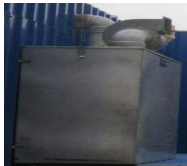
Module Deodoroxid, khử mùi của hệ thống xử lý nước thải.
