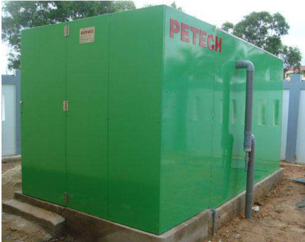
Hệ thống XLNT BIOFAST-M, chuyên dùng các Trung tâm y tế, y tế xã phường, cơ sở y tế tư nhân
