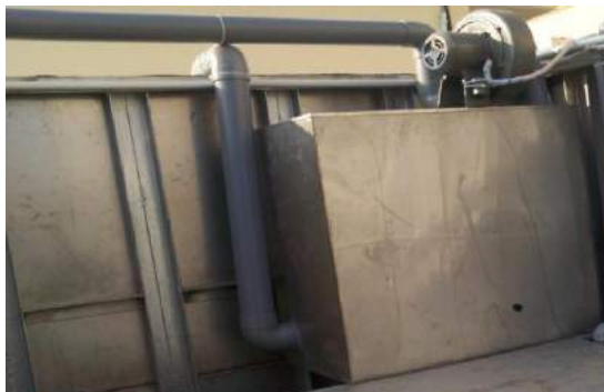
Module Deodoroxid, khử mùi của hệ thống xử lý nước thải.
