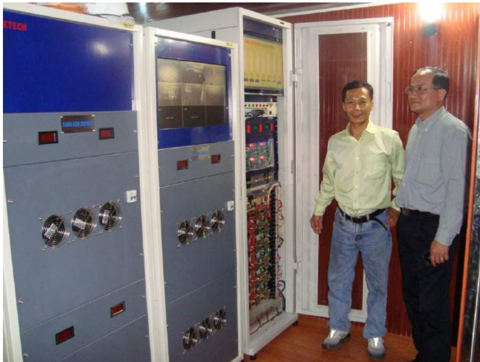
Hệ thống điều khiển hệ thống XLNT công suất 500m 3 /ngày
