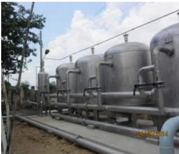
Xử lý nước giếng khoan công suất 100 – 10.000 m 3 /ngày
