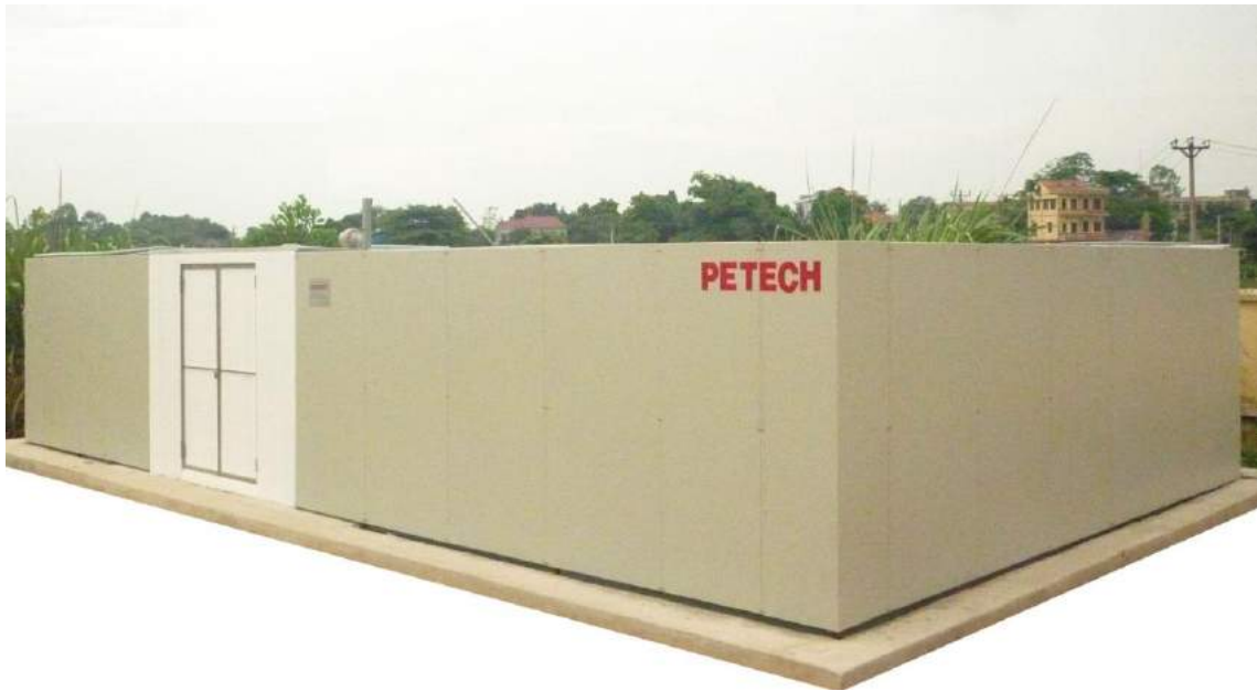
Hệ thống XLNT bệnh viện Gang Thép, công suất 150m 3 /ngày, đưa vào sử dụng tháng 6/2010
