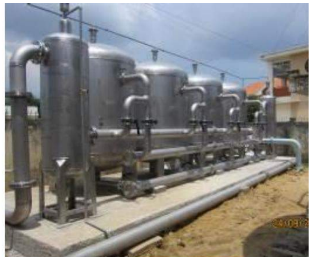
Xử lý nước giếng khoan công suất 100 – 10.000 m 3 /ngày
