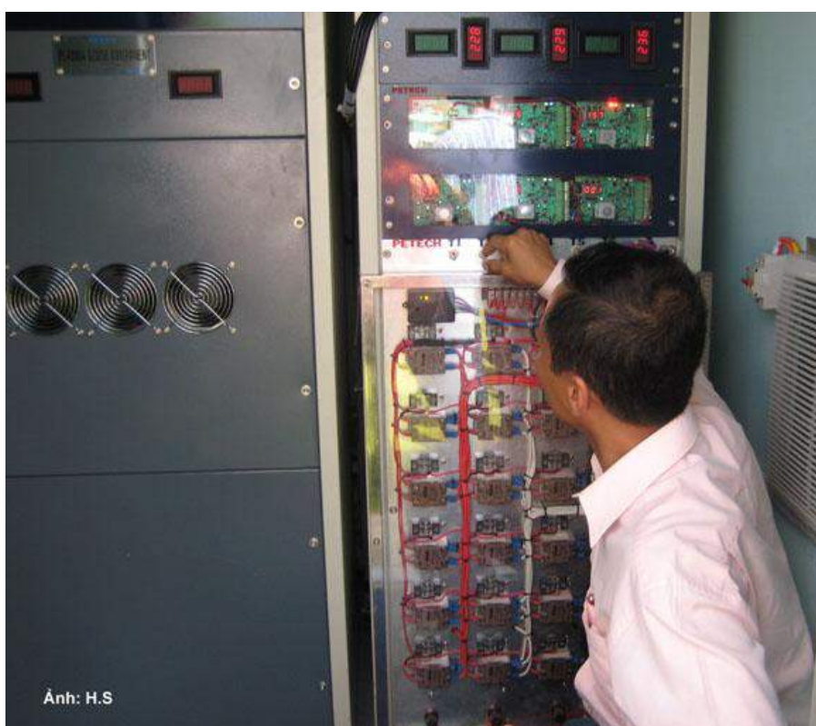
Ảnh: H.S KS. Phan Trí Dũng đang kiểm tra hoạt động của hệ thống xử lý nước thải bệnh viện tại Bệnh viện Chợ Rẫy.
