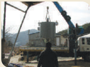
Lắp đặt lò phản ứng thử nghiệm
