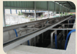
Lắp đặt sản phẩm nhà máy phân bón lỏng có khả năng xử lý 50 tấn/ngày
